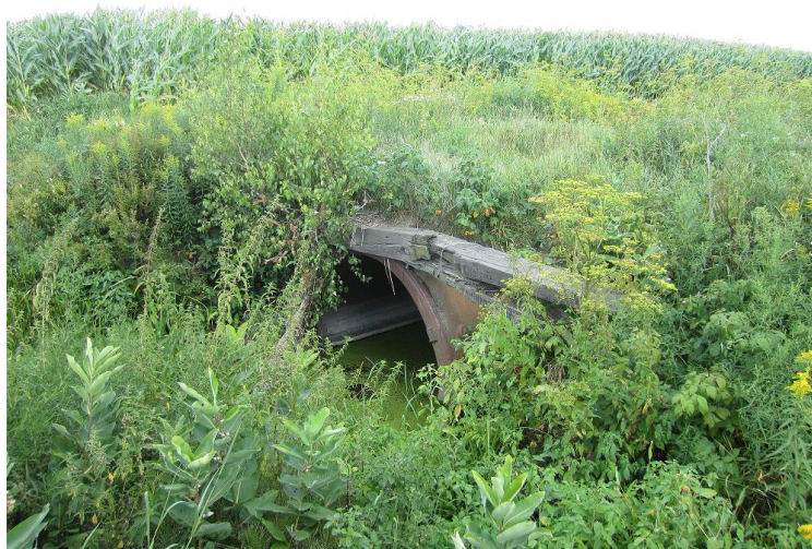
Figure 3.4: Ponceau situé dans le cours d'eau Grand Marais
