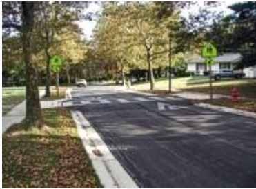
Avancée de trottoir
