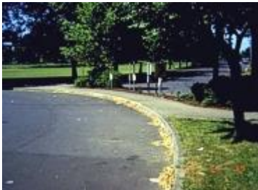
Barrière de déviation
